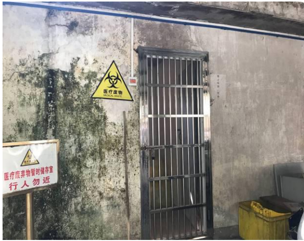
医疗废物暂存间
